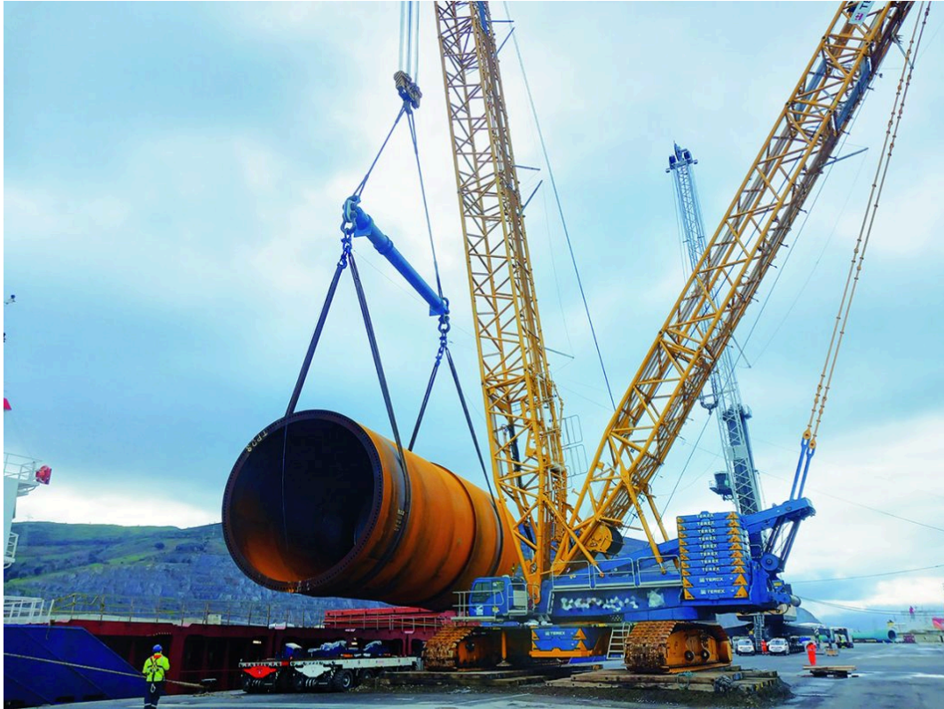
Las piezas eólicas pesan en torno a 300 toneladas cada una
