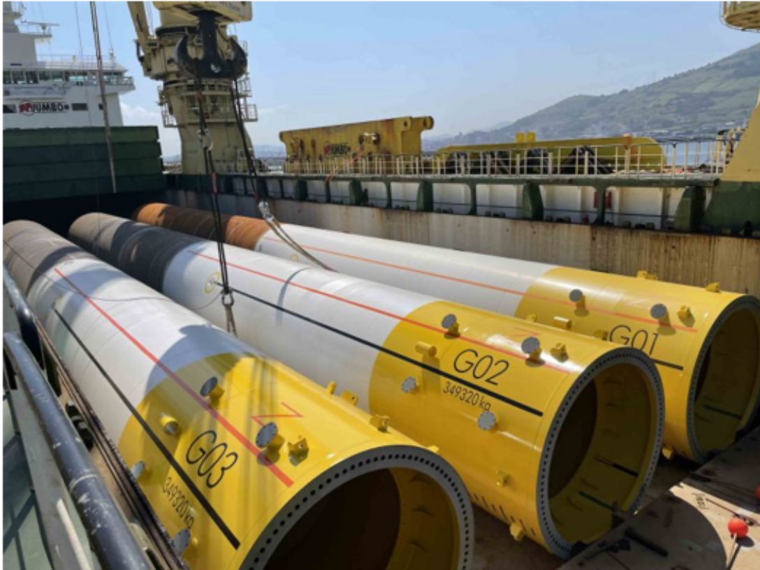
Se cargaron 10 monopilas de Haizea Wind destinados a la cimentación de los aerogeneradores de los parques eólicos marinos
