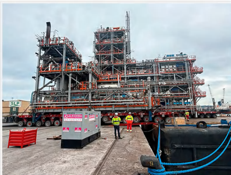
Operativa con la carga especial de SLP en el puerto de Bilbao.
