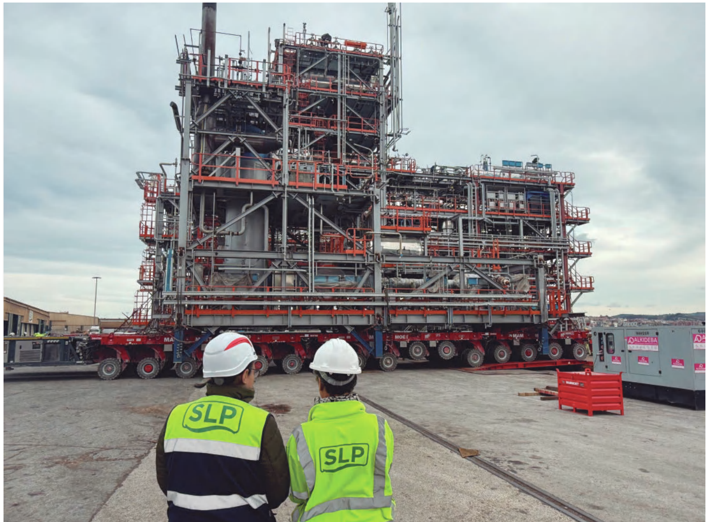
Las unidades cargadas en las instalaciones de SLP en el Muelle Adosado de Santurtzi tenían pesos unitarios entre 160 y 535 toneladas y alturas hasta 33 metros.
