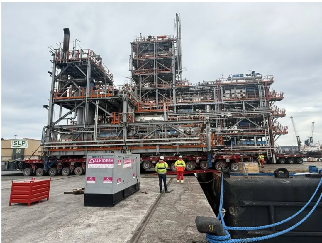
Carga en el puerto de Bilbao de uno de los módulos a la pontona, a cargo de SLP
